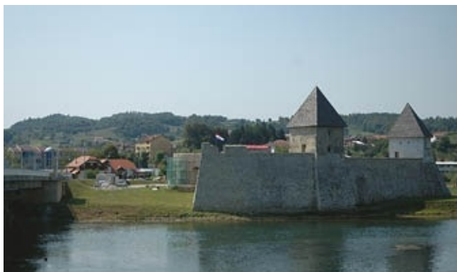
Vista del puente de Hrvatska Kostajnica.
