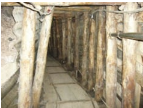
Túnel de Sarajevo.
